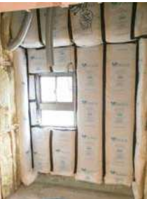
浴室外壁に断熱材を設置した例
