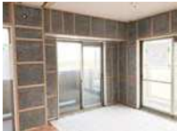
外壁の断熱改修
